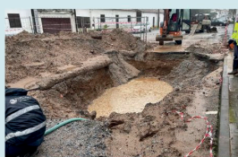
Reparação de Conduta Viana do Alentejo, 10 de fevereiro de 2026
